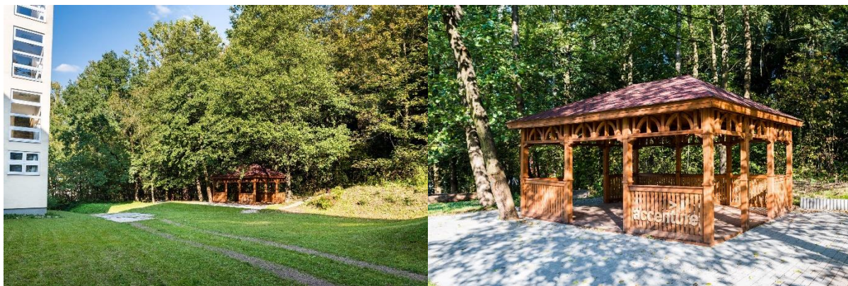
Obr. 86 Položenie zámkovej dlažby okolo altánku FRI
